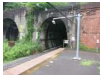
七釜・田浦トンネル
