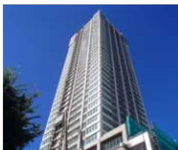
大湊町二丁目地区の再開発ビル
