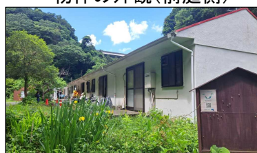
物件の外観(前庭側)
