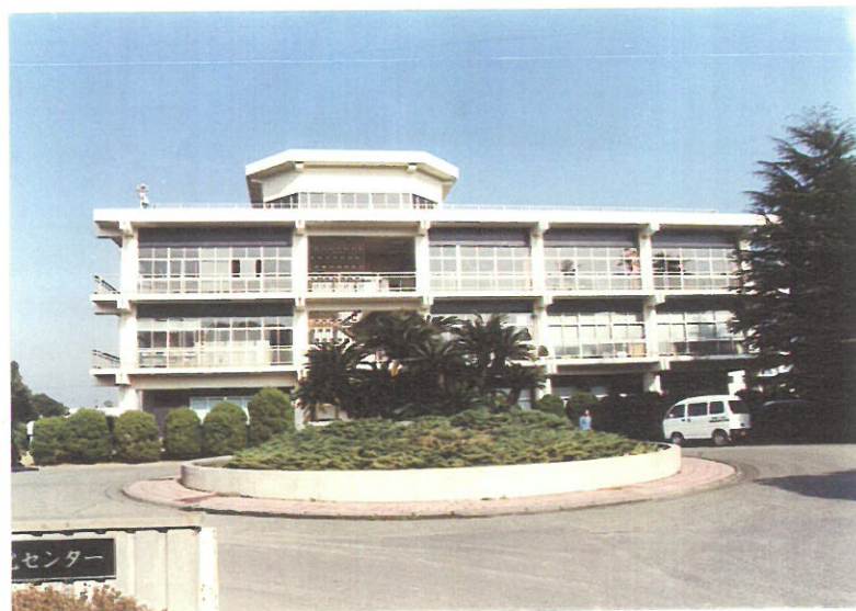
下町浄化センター
