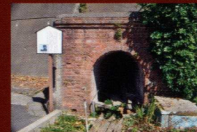
専用水道の坑門 イギリス積
