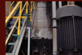
ポンプ室 イギリス積
