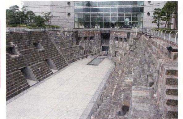
旧横浜船渠第2号ドック ドック底部は広場として、側面の内部は店舗として有効活用されています
