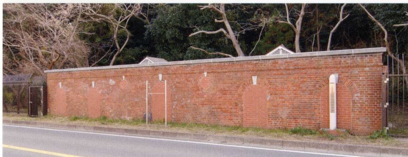
走水水源地煉瓦造貯水池（国登録有形文化財）
