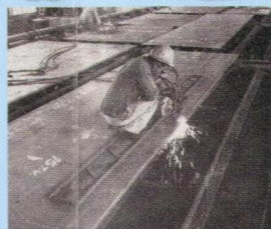
切断 (ガス切断)
