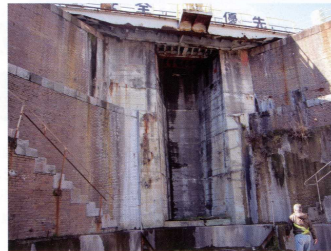
↑ドック内側から見た拡張部分(コンクリート造)
