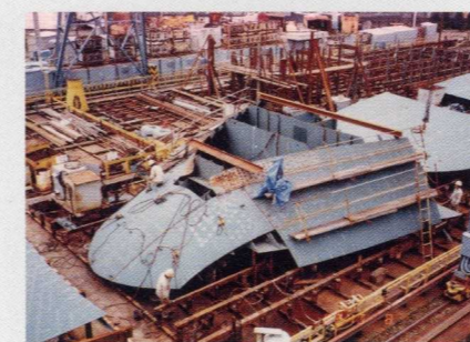
ブロックを反転させて作業
