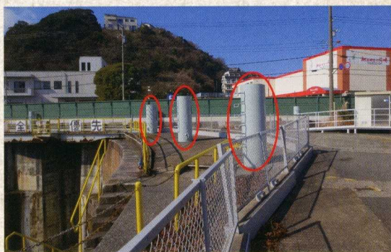
▲現在は上部が切り取られ、撤去されている。
