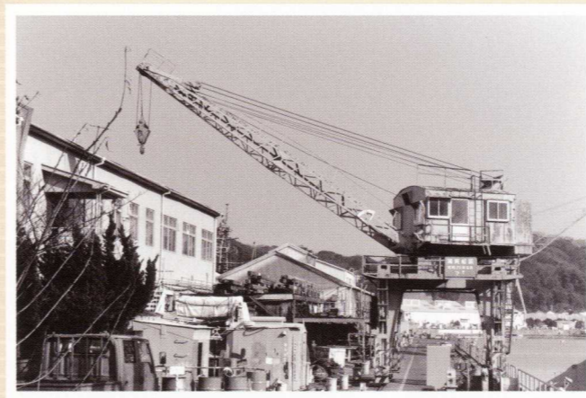
小型クレーン
