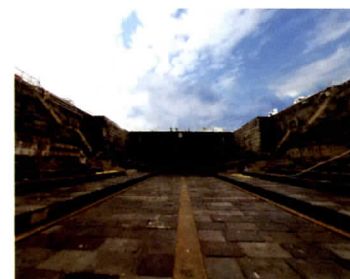
③横須賀海軍施設1号ドック(1871年竣工)
