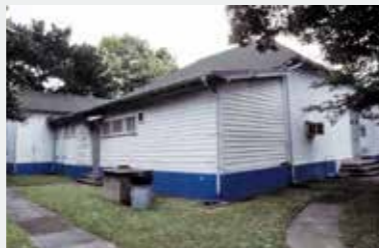
解体前のティポディエ邸外観
