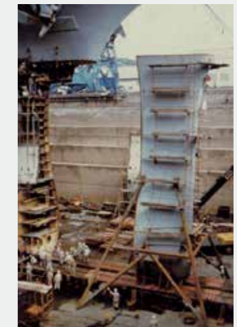
撤去した部分と同型のブロックの取付け
