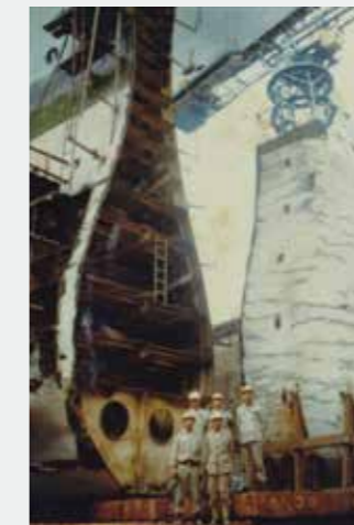
破損した艦首を撤去
