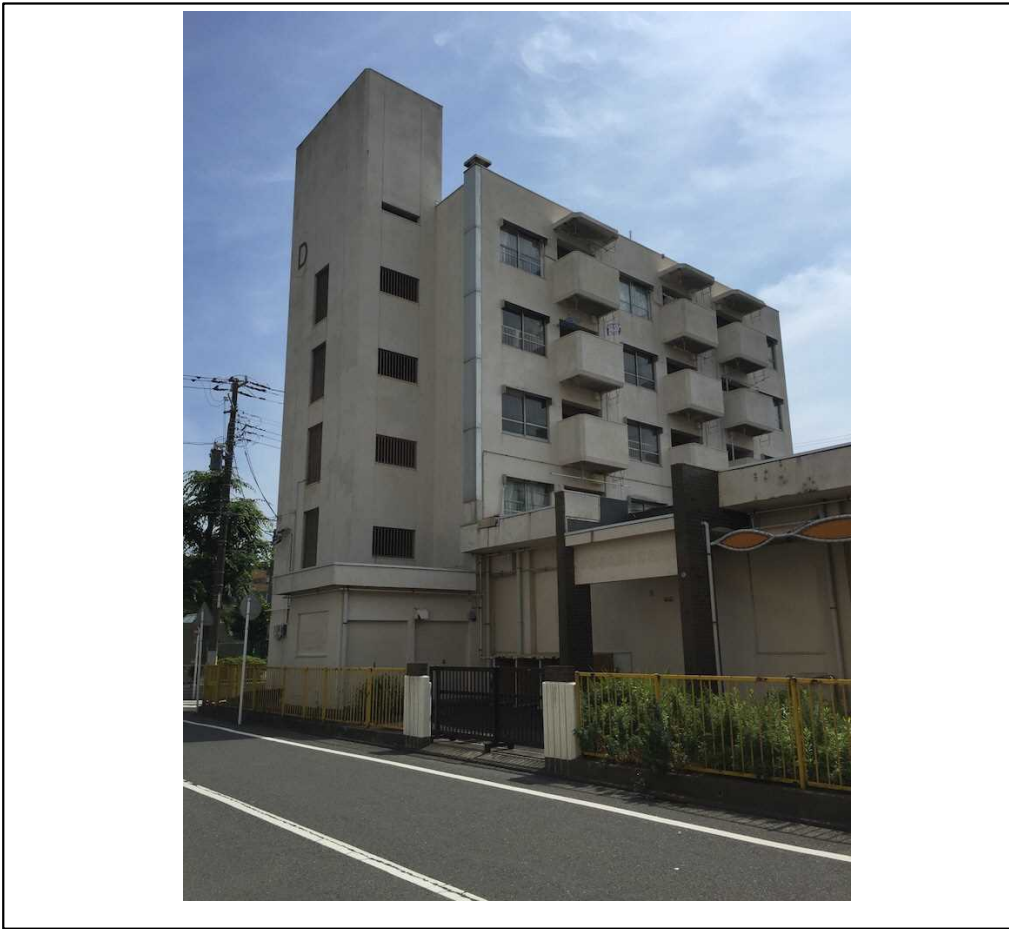
図表 5 D棟（南側から）
