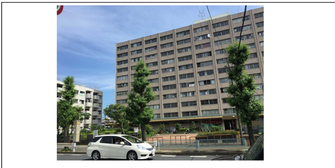
図表 2 A棟（南側の市道から）
