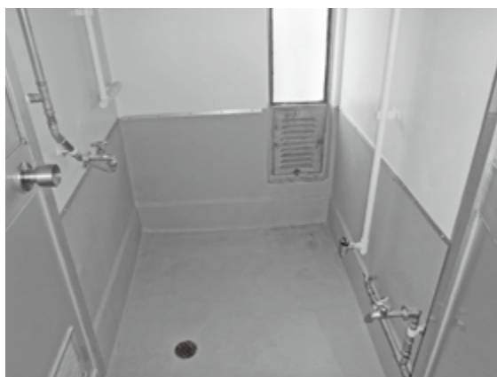
※お風呂設備がない浴室
