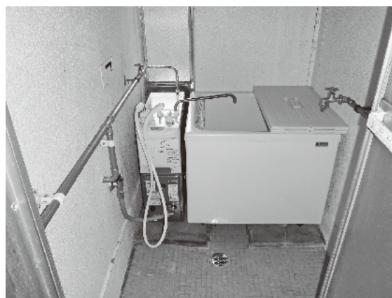
※バランス釜設置後の浴室
