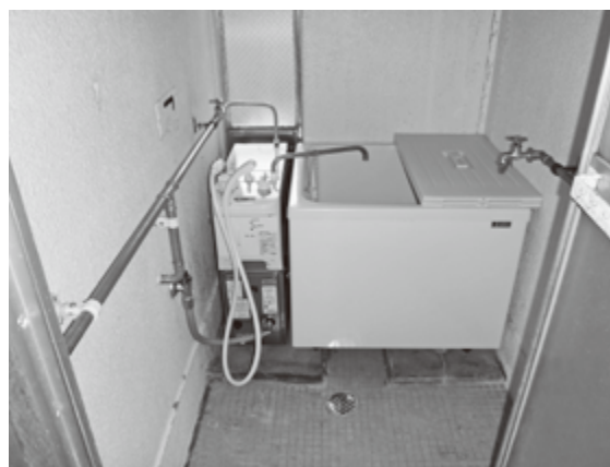
※バランス釜設置後の浴室
