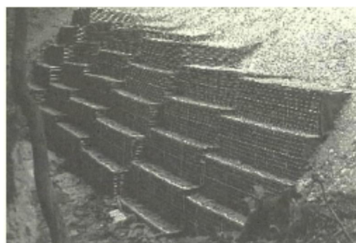
写真８－２ 大型かご枠工 (盛土等防災マニュアル抜粋)
