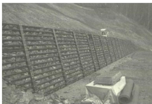
写真８－１ 鋼製枠工 (盛土等防災マニュアル抜粋)
