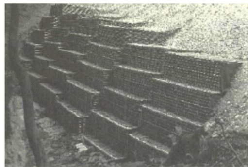
写真8-2 大型かご枠工 (盛土等防災マニュアル抜粋)
