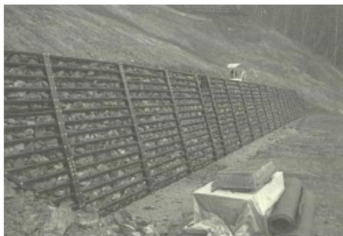
写真8-1 鋼製枠工 (盛土等防災マニュアル抜粋)
