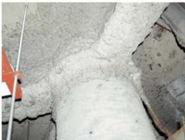
鉄骨耐火被覆
