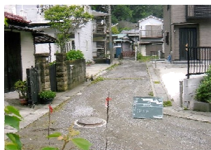
私道整備施工前
