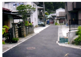
私道整備施工完了後
