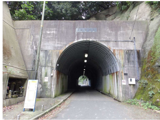
長瀬トンネル
