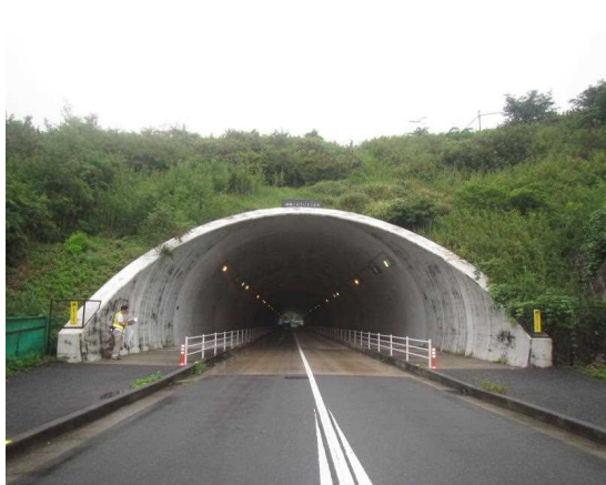
佐島しおさいトンネル
