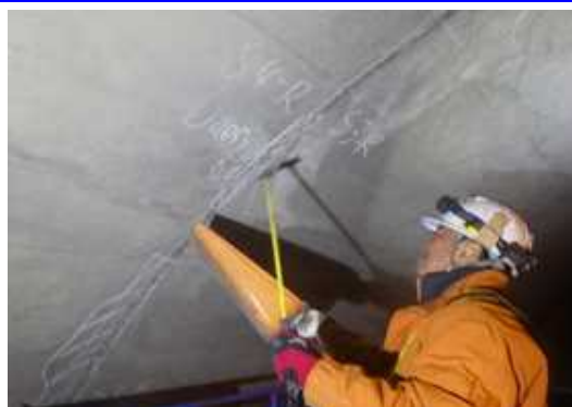
写真6-1 トンネル点検状況
