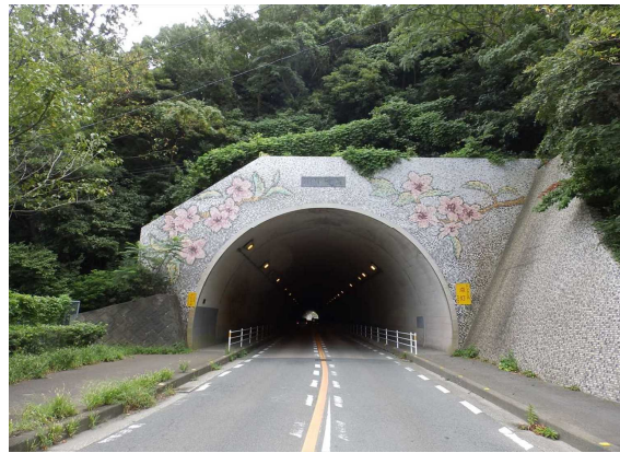
川間トンネル
