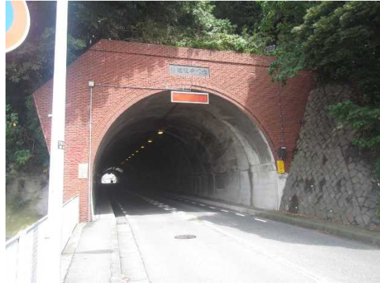
大明寺トンネル
