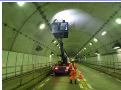
写真6-1 トンネル点検状況
