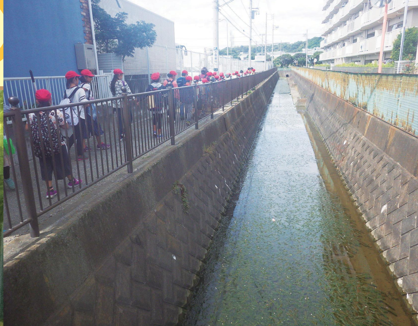
コンクリートで護岸された川に繁茂するオオカナダモ
