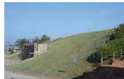
耐震性貯水槽が埋設された築山遊具
