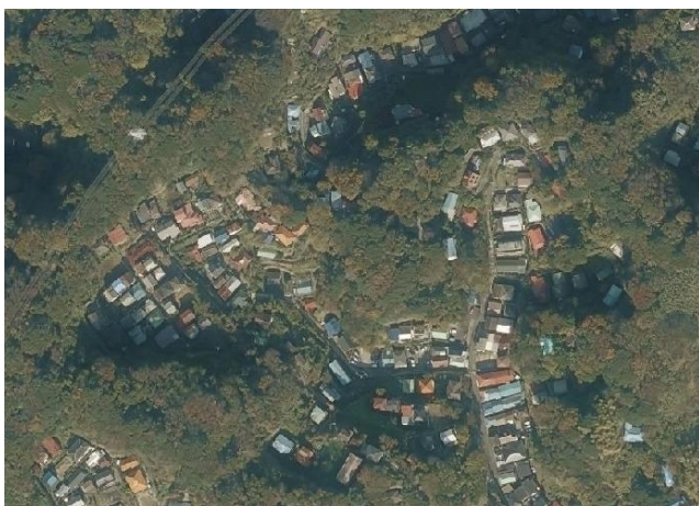
斜面地と近接した民家（横須賀市内の谷戸地域）
