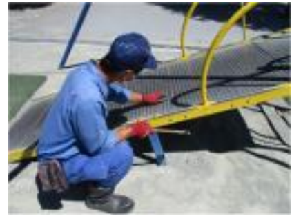
公園パトロールによる日常点検
