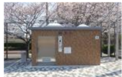
神明第2公園（トイレ、園路整備）
