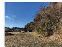
⑦ がけ崩れが発生した形跡
