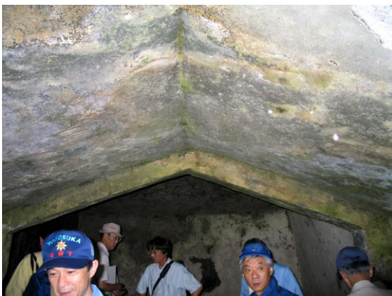
1号穴前室と後室との境
