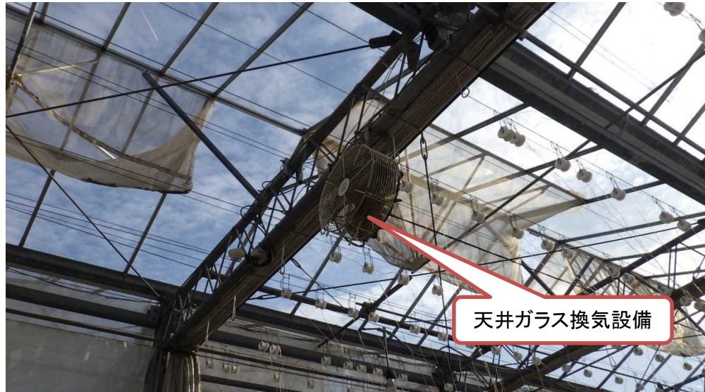
天井状況③
