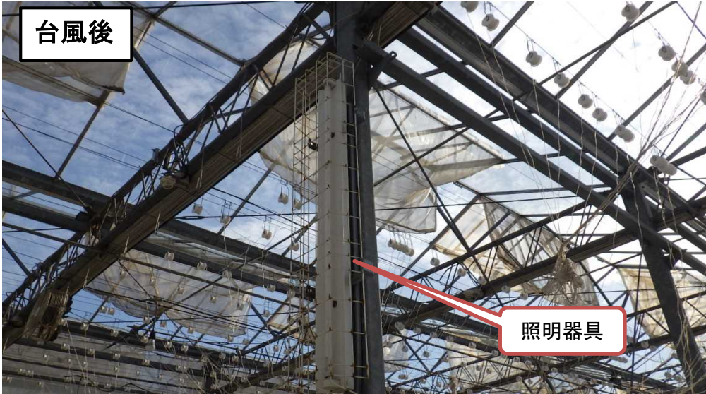
天井状況①
