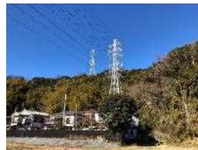
対象地内の鉄塔2基
