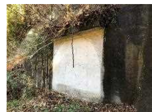
コンクリートで塞がれた 弾庫跡地
