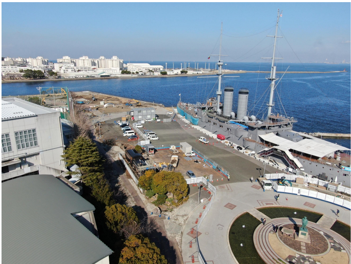
入口から海側
