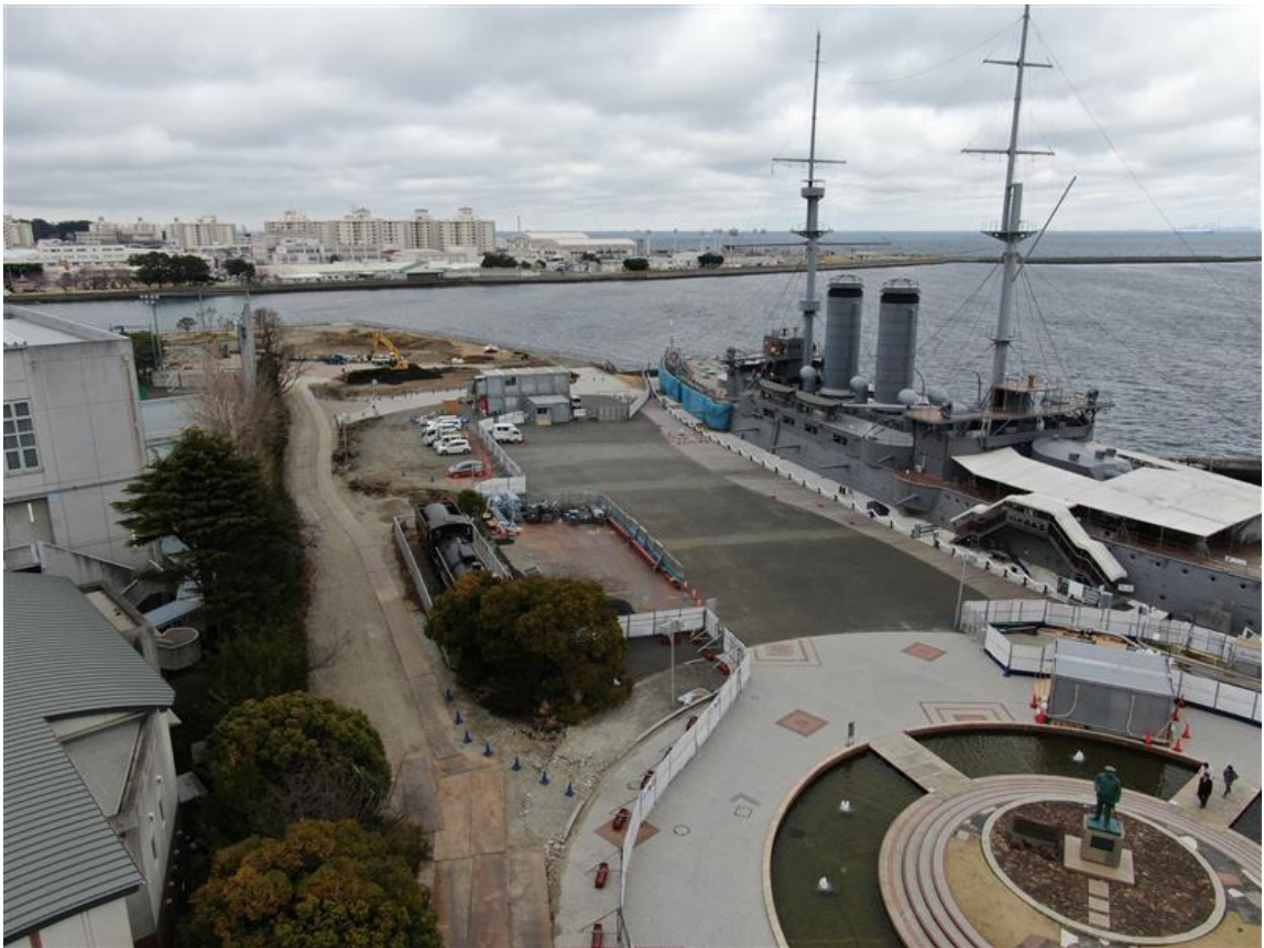
入口から海側
