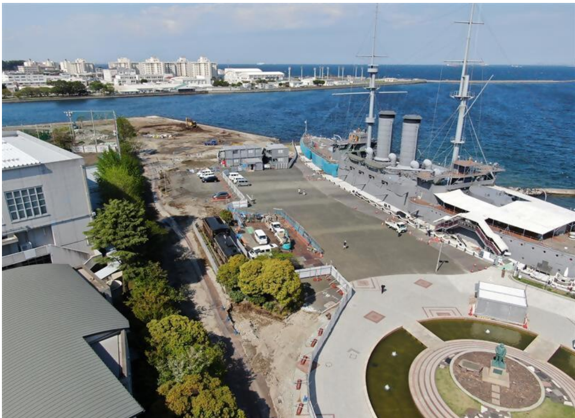
入口から海側
