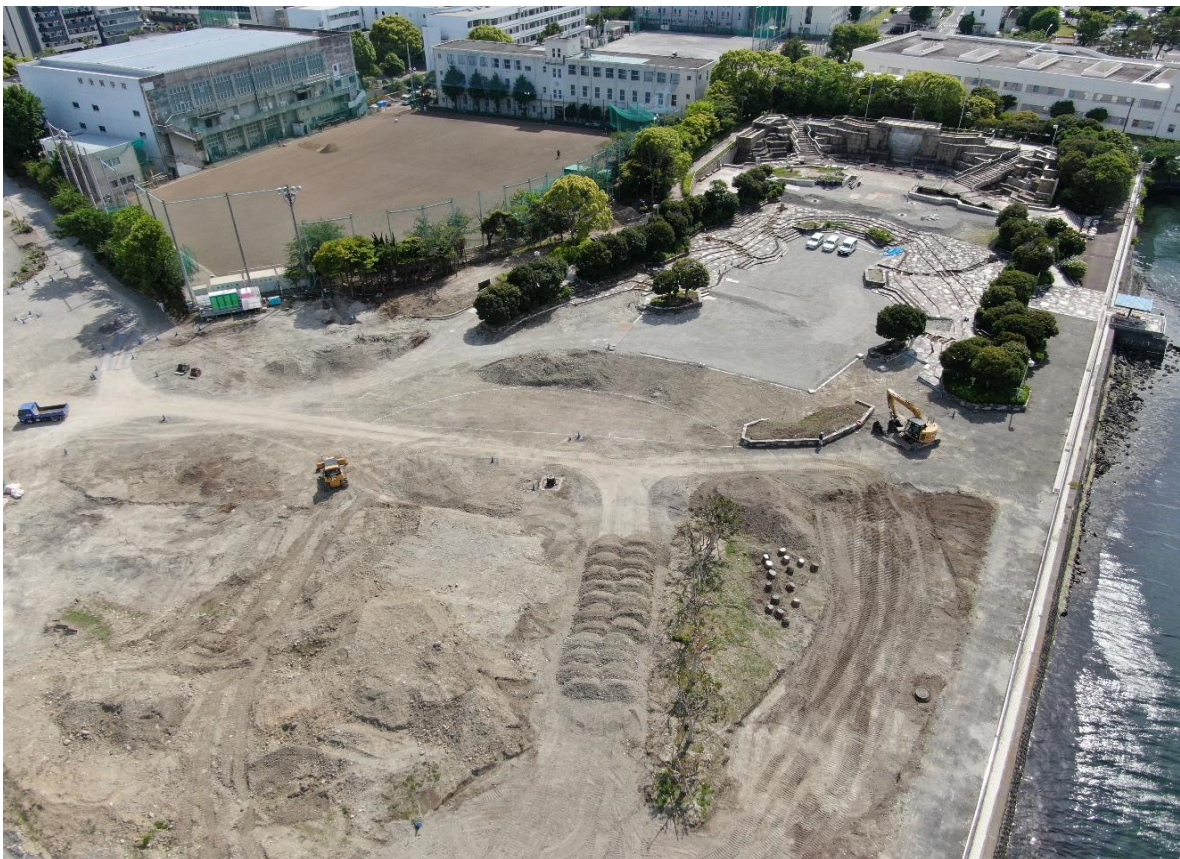
海側から旧音楽噴水池
