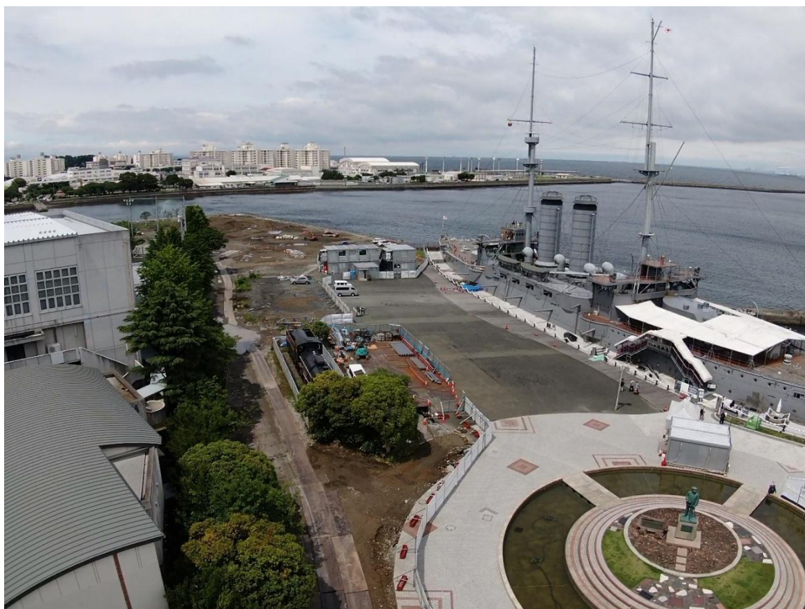
入口から海側
