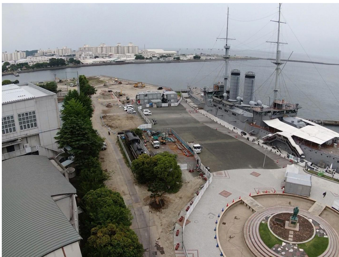
入口から海側
