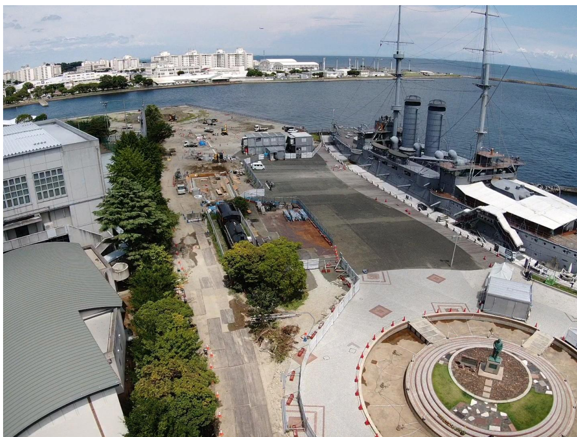
入口から海側
