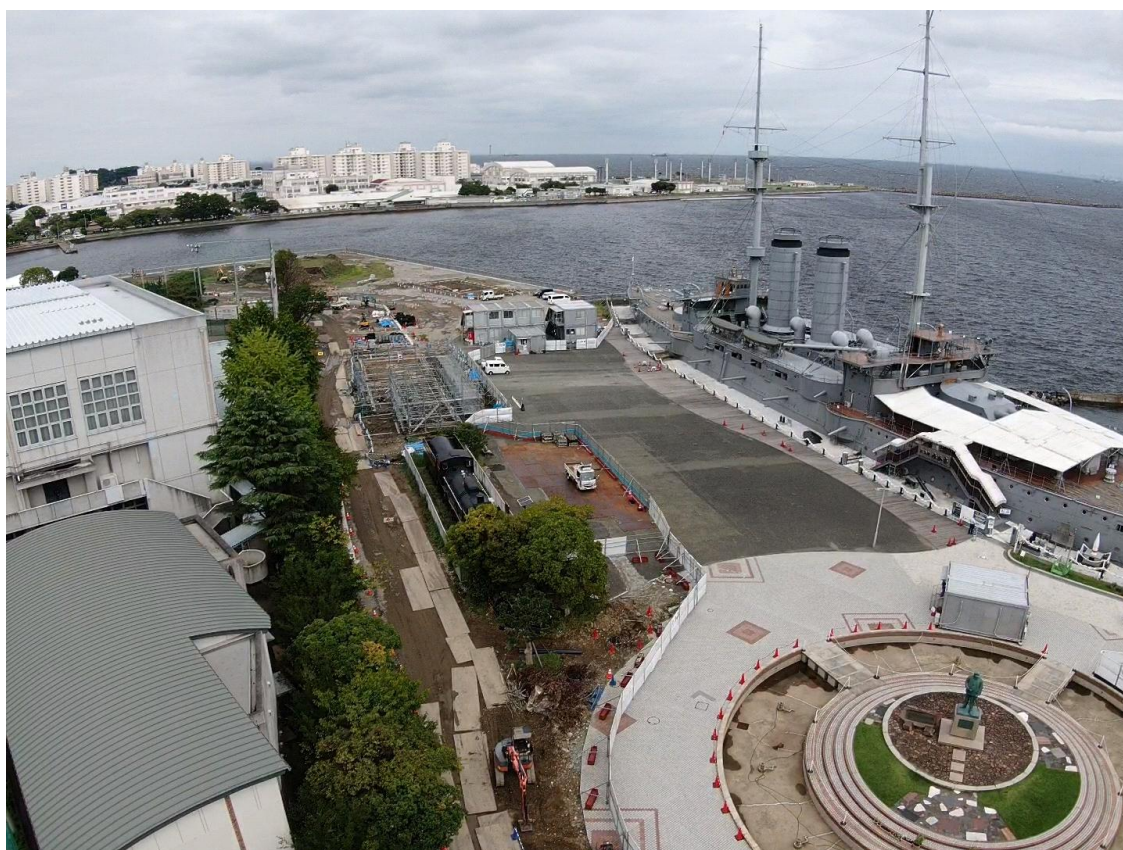
入口から海側
