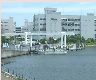
大森ふるさとの浜辺公園（東京都） 防災クレーン
