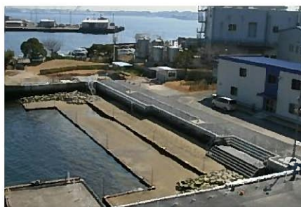
人工干潟を用いた生物共生護岸「潮彩の渚」 （出典：国土交通省横浜港湾空港技術調査事務所HP）
