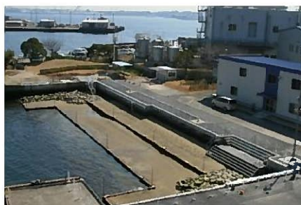
人工干潟を用いた生物共生護岸「潮彩の渚」 （出典：国土交通省横浜港湾空港技術調査事務所HP）
