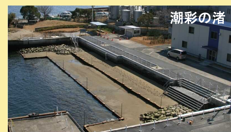
汚泥の除去、覆砂の実施、干潟の再生等による環境改善
