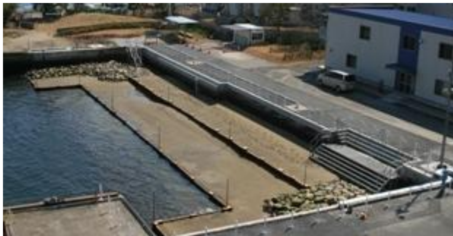
人工干潟を用いた環境共生護岸『潮彩の渚』 (出典:国土交通省横浜港湾空港技術調査事務所HP)
