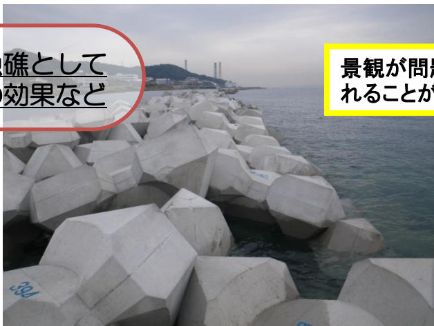
消波ブロックによる傾斜堤の例
