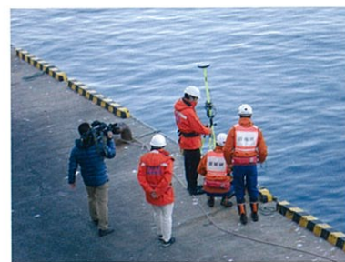
2. 着岸可否判断のための岸壁調査
