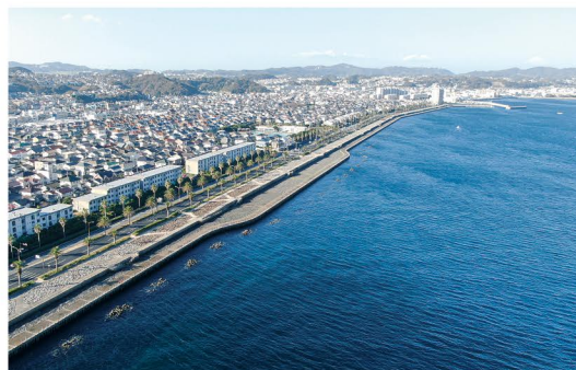
馬堀海岸高潮対策護岸（馬堀地区）
