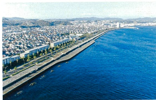
馬堀海岸高潮対策護岸（馬堀地区）
