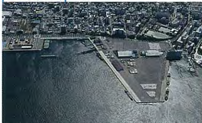
中心市街地に隣接する横須賀港随一の規模を持ち、SOLAS条約に基づく港湾施設保安計画に対応した国際ふ頭です。
