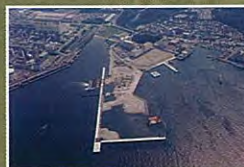
建設中の久里浜地区
