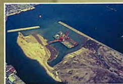
建設中の平成地区
