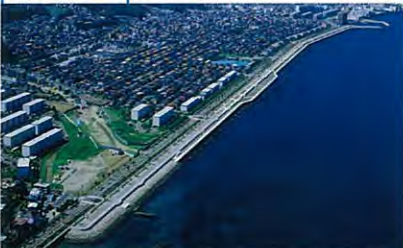
平成7,8年の台風により、馬堀海岸一帯が浸水しました。その対策として親水性を備えた面的防護方式護岸の整備を行いました。
