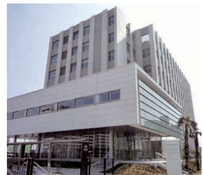
横須賀地方合同庁舎
