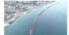
約5km(港湾区域内は約2km)の砂浜が広がっています。海岸侵食による背後地への被害を防ぐために、離岸堤等の整備を進めています。
