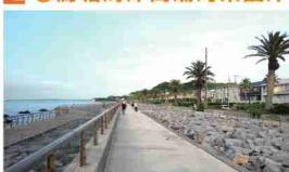
高潮による被害を防止するための護岸です。静穏時には、親水施設として、護岸上部を歩けるプロムナード構造となっています。
