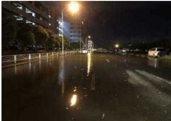
臨港道路浸水
